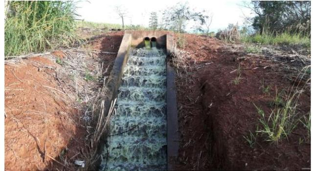
Foto 3.26 – Tubulação de saída do esgoto, encaminhamento para o corpo receptor
